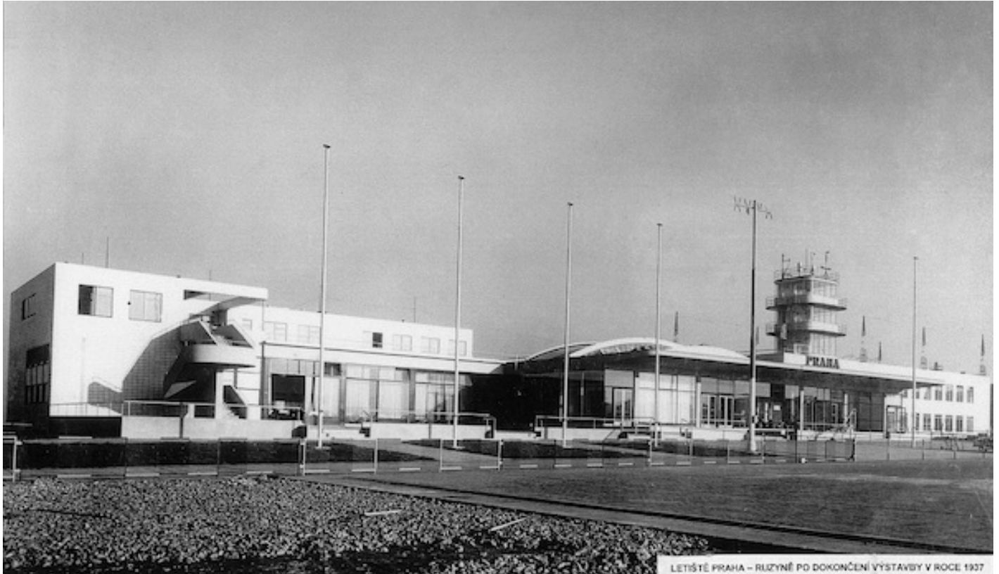
LETIŠTĚ PRAHA – RUIZYNĚ PŮD DOKONČENÍ VÝSTAVBY V ROCE 1937
